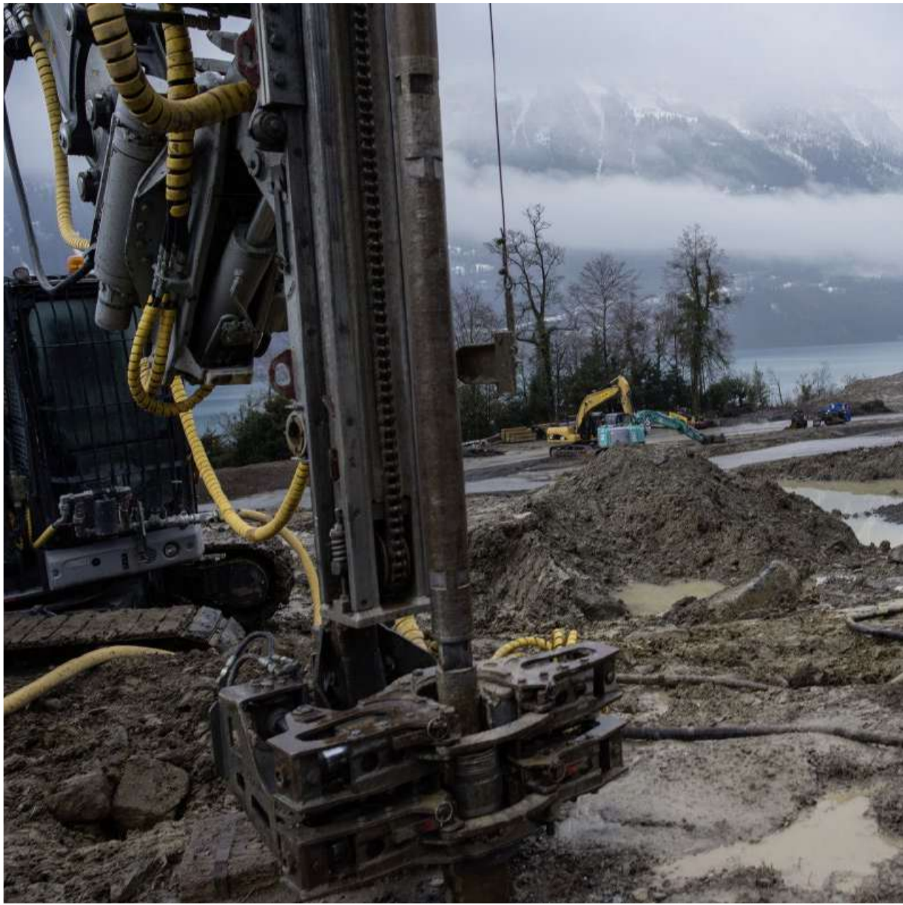
Mitten auf der Baustelle in Oberried steht, urchig und denkmalgeschützt, das ehemalige Gasthaus Moospinte. Es soll als Luxus
